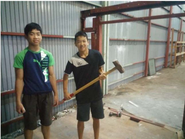
事務所の一部を解体。助走スペースをつくる！
