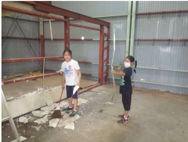
解体して掃除して掃除して(;^_^A アセアセ・・・
