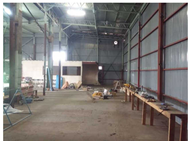
反対側はまだ工事現場！
